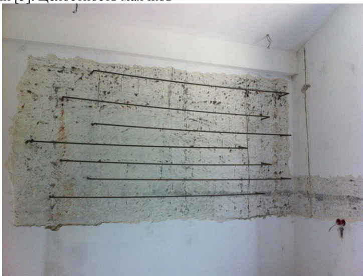
Рис. 9. Выполненное на объекте усиление стен с трещинами
